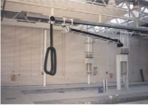
Die **AFA TRUCK-LINE** befasst sich mit den Saugschlitzkanälen Typ AFA für LKW und Omnibusse. Ebenfalls größte Flexibilität in einer Achse und ausreichendes Absaugvolumen am benötigten Arbeitsplatz. Die Saugschlitzkanäle sind in der Länge variabel und können die Gruben komplett abdecken, d.h. es können Auspuffrohre an allen Positionen auf einer Seite erreicht werden egal ob vorne, in der Mitte oder hinten.
