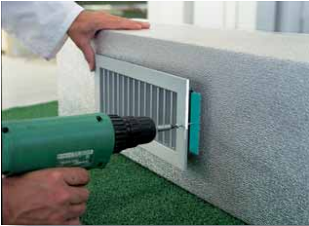
Montaža prezračevalnih rešetk
